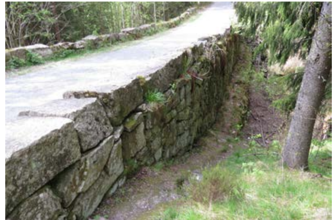
Den bergensk kongeveg gikk over Bjøråsen inntil 1818. Den er truleg bygd som køyreveg under Georg Anthon Krogh i 1777. Den vart bygd om under generalvegmeister Lars Ingier til ein viadukt i 1790-åra. Ein ser den eldre vegen som eit fundament under viadukten. (Foto Geir Paulsrud)
