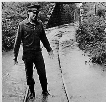
11. august var det et voldsomt regnvær, og ved undergang Vingerbanen stod vannet over skinnegangen. Togene ble trukket over med diesel. Her ser vi en fortvilet BM Hohle. (Erik Borgersen)
