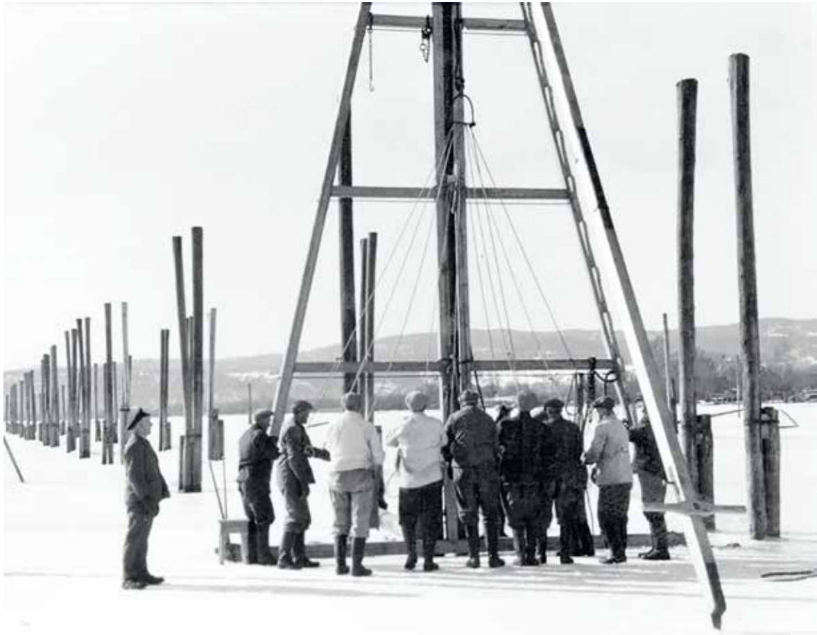
Ti arbeidere trakk i 10 tauender som var festet til en ring. For at arbeiderne skulle holde takten, sang pålebasen (formannen) en oppsang. Foto Norsk Skogmuseum.
