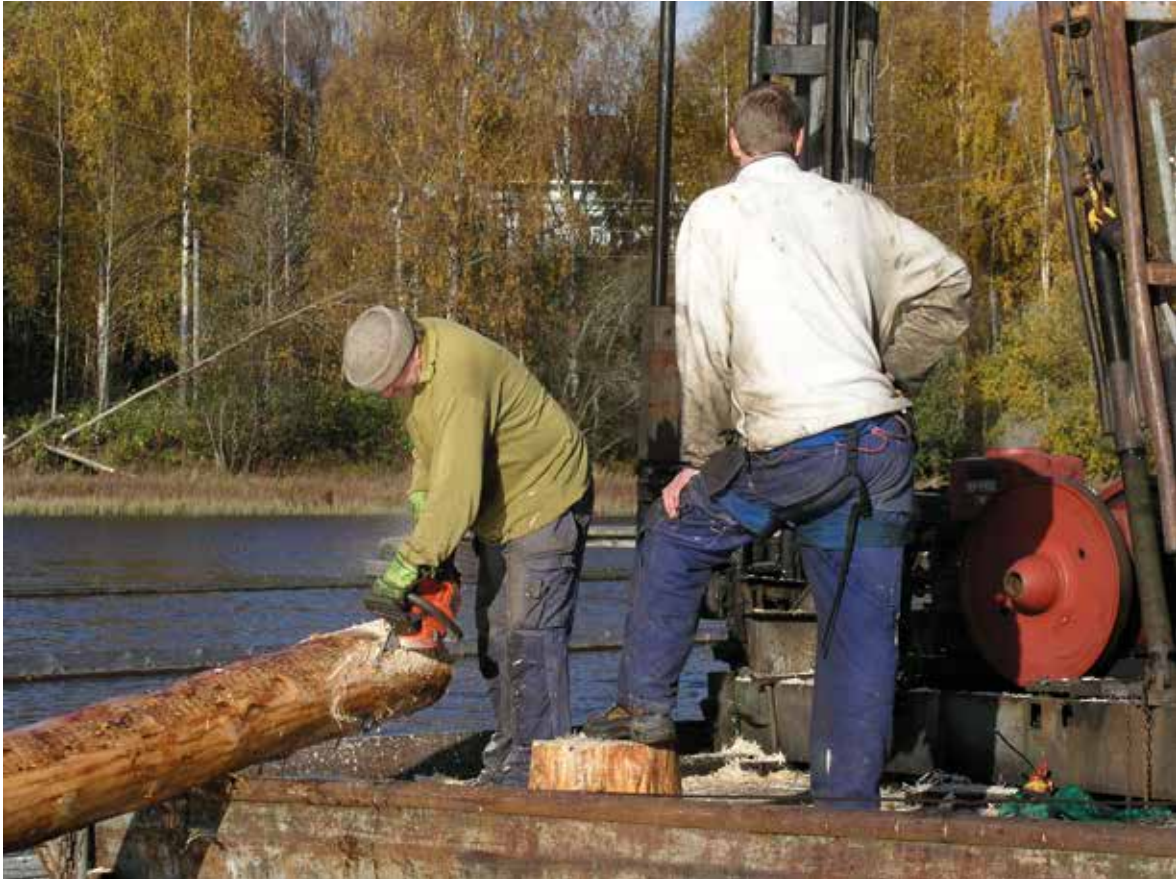
Over: Pålen spisses med motorsag. På bildet ses lensenes håndverkere Bjørn Sundbakken (venstre) og Haakon Skoglunn (høyre). Under: Ferdig spisset pål.
