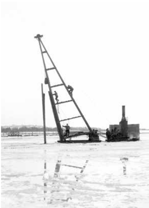
Galgebygging med dampdrevet pålebukk ved Fetsund Lenser. Foto Norsk Skogmuseum.
