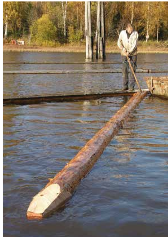
Over: Pålen spisses med motorsag. På bildet ses lensenes håndverkere Bjørn Sundbakken (venstre) og Haakon Skoglunn (høyre). Under: Ferdig spisset pål.
