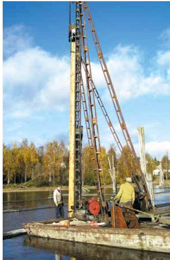
Pålen ferdig montert på pålebukken.
