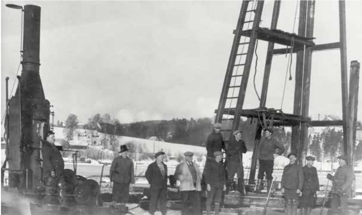
Den dampdrevne pålebukken med mannskap 1942-1944. Foto: Arild Buvik.
