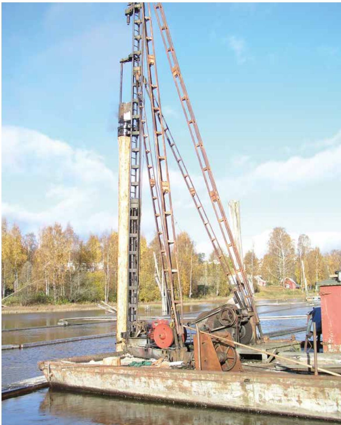
Dieselramloddet slippes ned på blokken.
