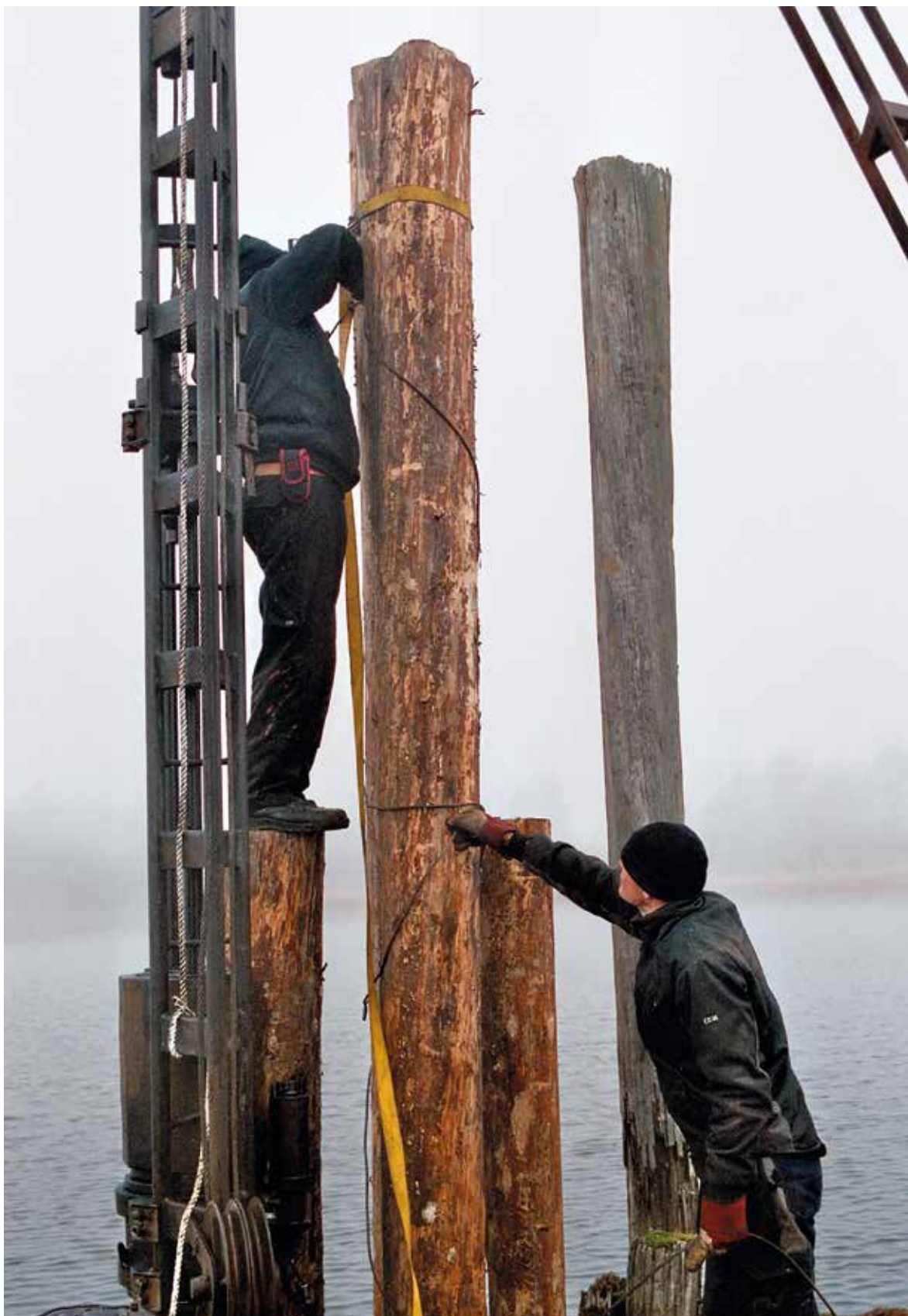
Over og øverst neste side: Pålene i et pålebind holdes sammen med vaier. Pålene samles med lastestropp før vaieren monteres. Nederst neste side: Bjørn Sundbakken smir kramper til feste av vaier.
