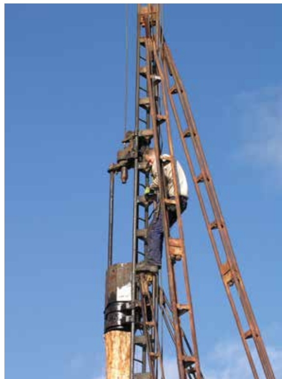
Nåla (splinten) er fjernet, og selve pålingen kan begynne.
