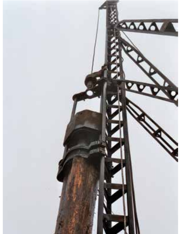
Loddet smeller ned i blokka ca. 68 ganger i minuttet. Antall slag avhenger av bunnforholdene.
