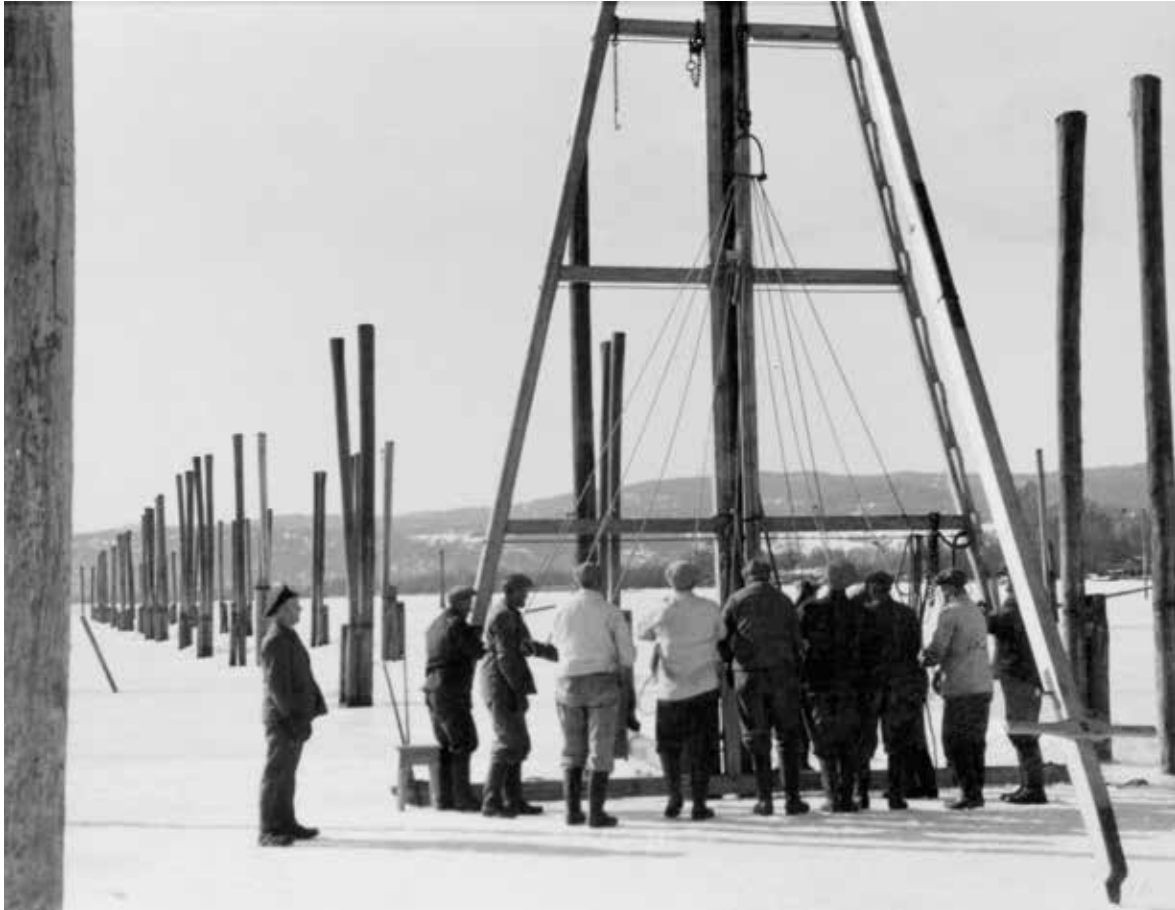
Manuell påling i 1950-årene. Legg merke til alle pålene og pålebindene på bildet. Hogging av is rundt disse var en del av vinterarbeidet. Foto: Norsk skogmuseum.
