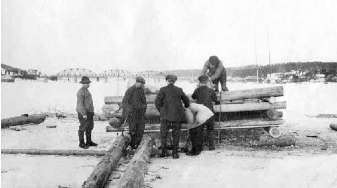
Bygging av skjerm på isen ved Fetsund lenser i 1917. I bakgrunnen sees dagens jernbanebru under oppføring. Foto: Norsk skogmuseum.
