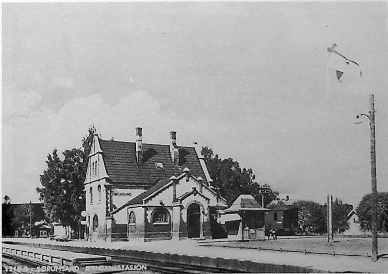
Sørumsand stasjon en fin sommerdag ca. 1949. Stasjonen har fått høytaleranlegg. CF05 eller CF06 sees bak Glosimodt-kiosken. Elektrifiseringsarbeidene på Kongsvingerbanen nådde Sørumsand i 1950. Foto: Mittet. UHB's fotoarkiv.
