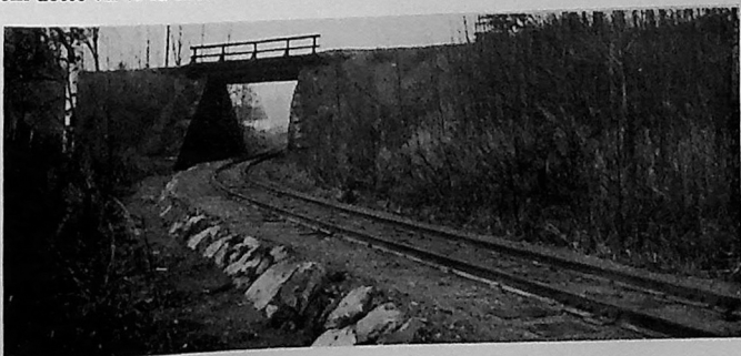
Nesten "Neu- baustrecke" etter avd.ing. og sysselsattes innsats mellom Presterud plo. og tunnelen.
