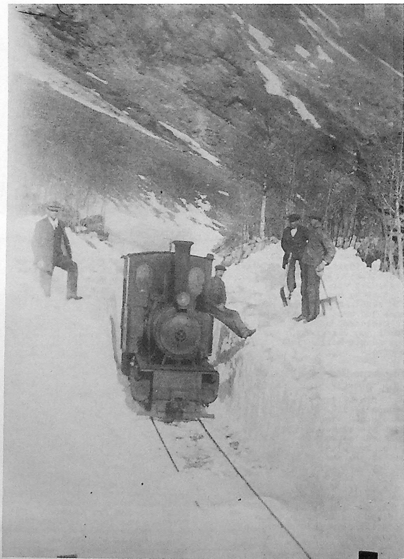
Snøen var ofte et problem på Aurabanen. Mens fjellstrekningen kun var i drift noen knappe måneder fra St. Hans, var det helårsdrift fra Sunndalsøra og inn til Dalen. Her er Aura nr. 1 ute med et arbeidslag.
