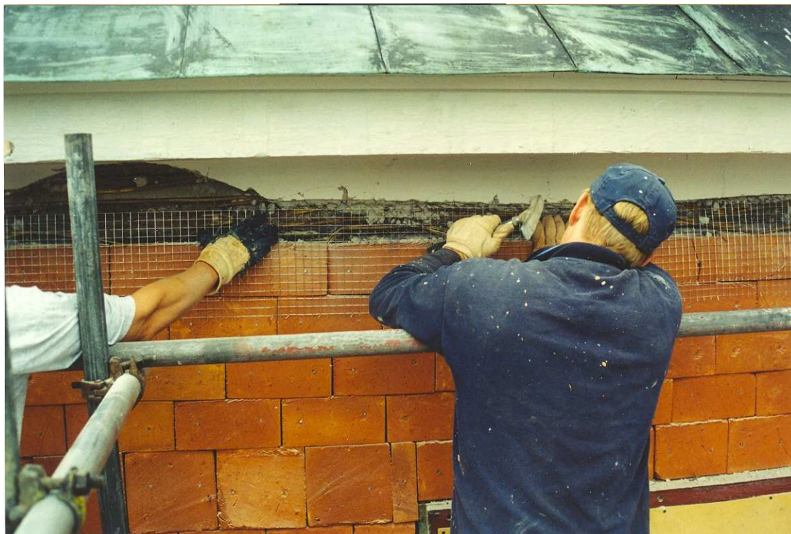
Montering av nät. Film nr. 2550
