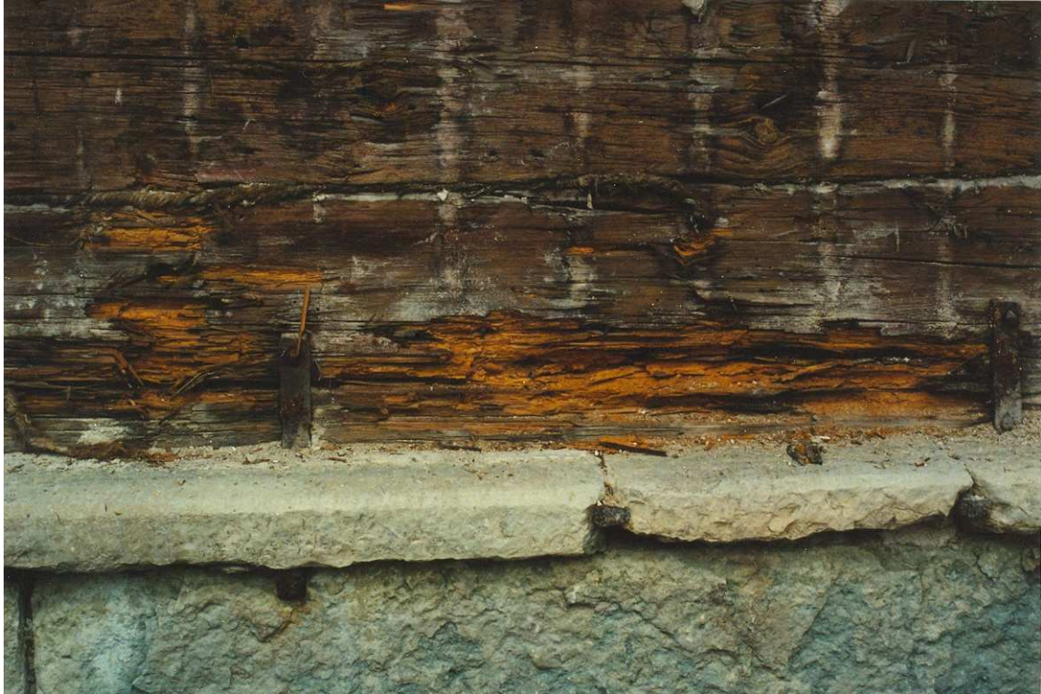
Rötskador i syllen. Film nr. 2542
