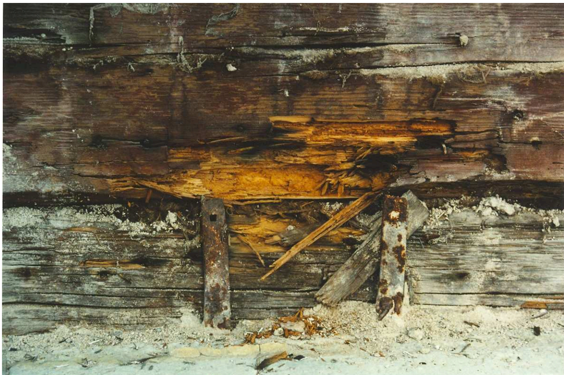
Rötskador i syllen. Film nr. 2542
