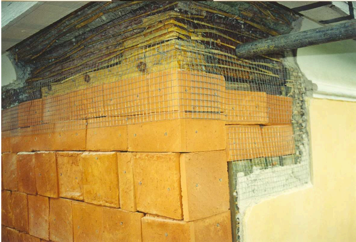
Övergången mellan tegel och takfot täcktes med nät som underlag för takfotslisten. Film nr. 2543
