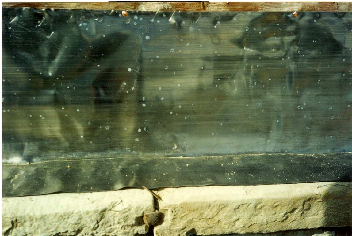
Blyplåten monterad på södra fasaden. Foto Jeanette Ekebergh-Frondell.
