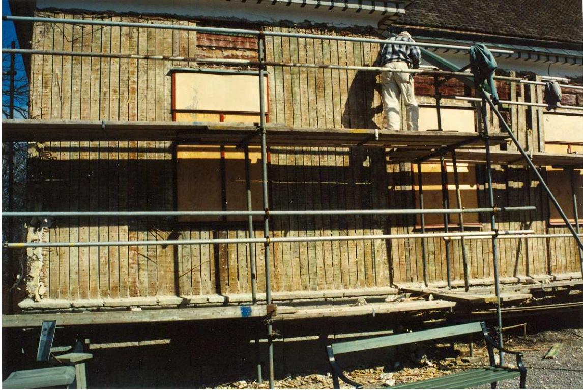
Rivning av panelen. Film nr. 2542
