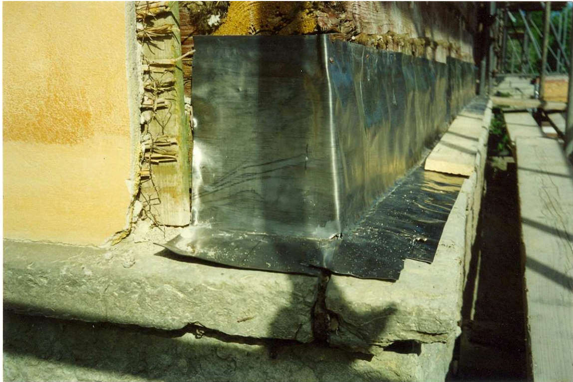
Blyplåten monterad på södra fasaden. Foto Jeanette Ekebergh-Frondell.
