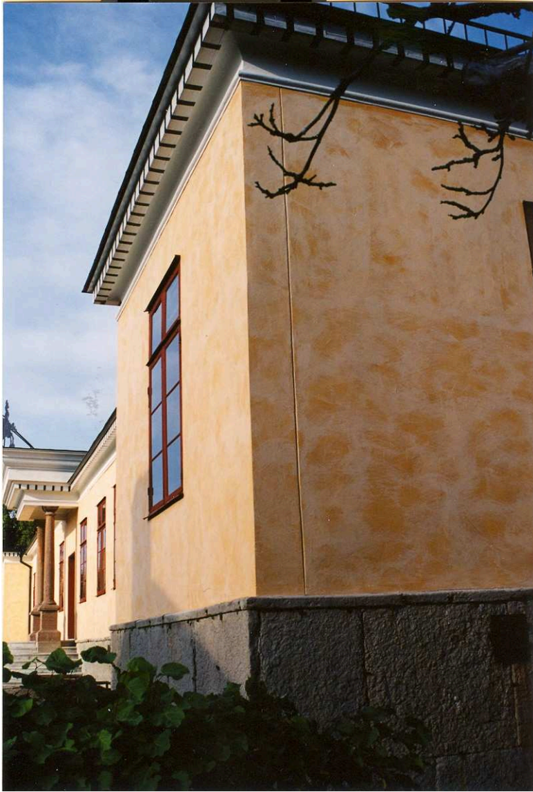
Skarven mellan gammal och ny fasad. Film nr. 2746
