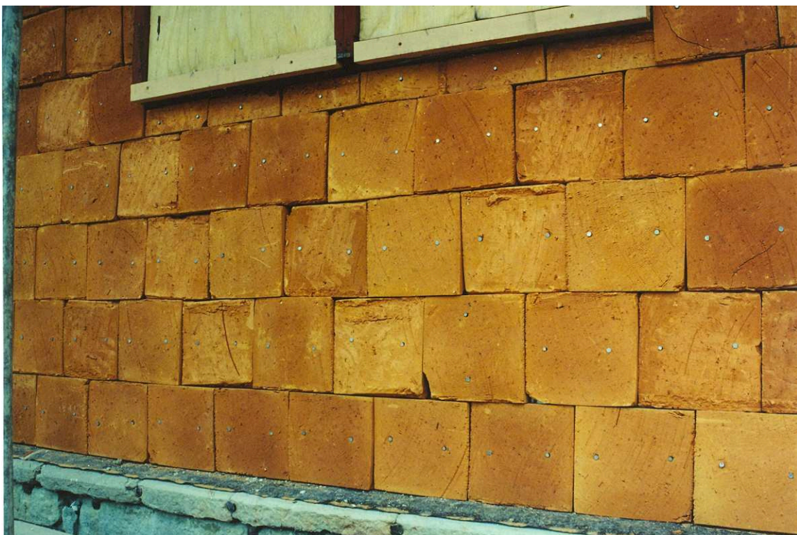
Detalj av spiktegel under fönster. Film nr. 2543
