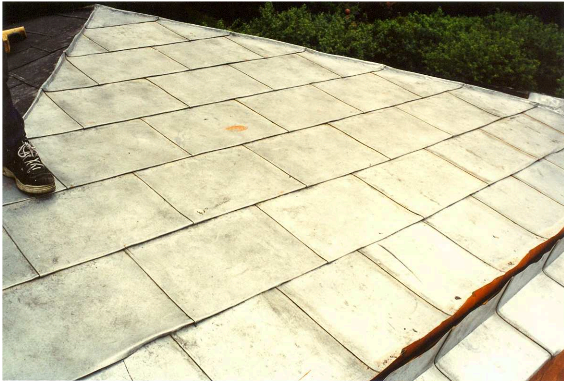
Ny plåt på östra paviljongens tak. Film nr. 2550
