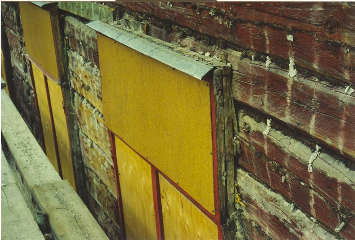
Fönster i östra delen. Film nr. 2548
