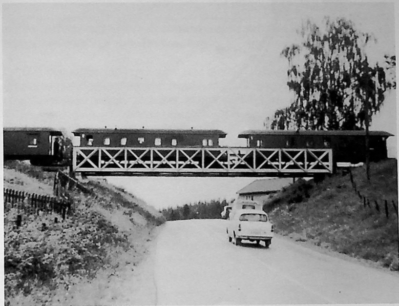
Bro over riksveien må vi ha, uansett lengde på forlengelsen. Her ser vi Fossum bro i 1960. Den var 20 meter lang og veide 25 tonn. (Foto: Jan Lysaker)
