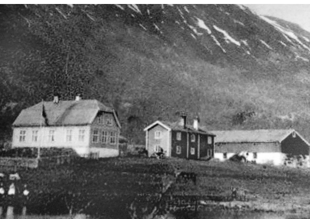
Moen prestegard, med Madame Knoffs bygning.
