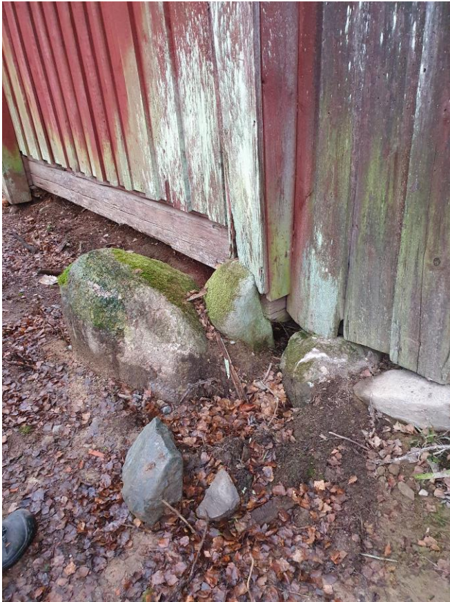
Ena knuten till logdelen ser ut att ev ha glidit av en grundsten.
