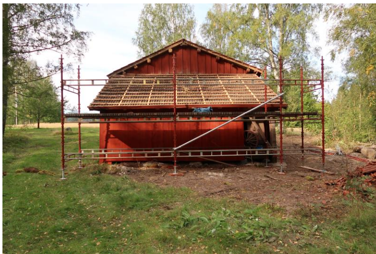
Under arbetets gång, teglet har plockats av.
