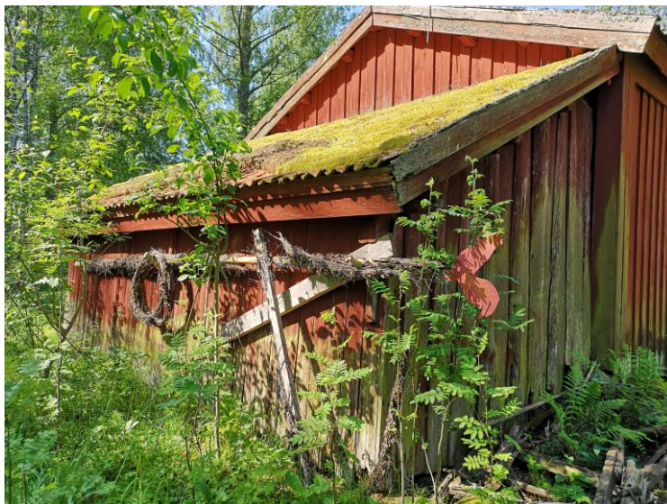
Lilla tillbyggnaden i öster före åtgärder.
