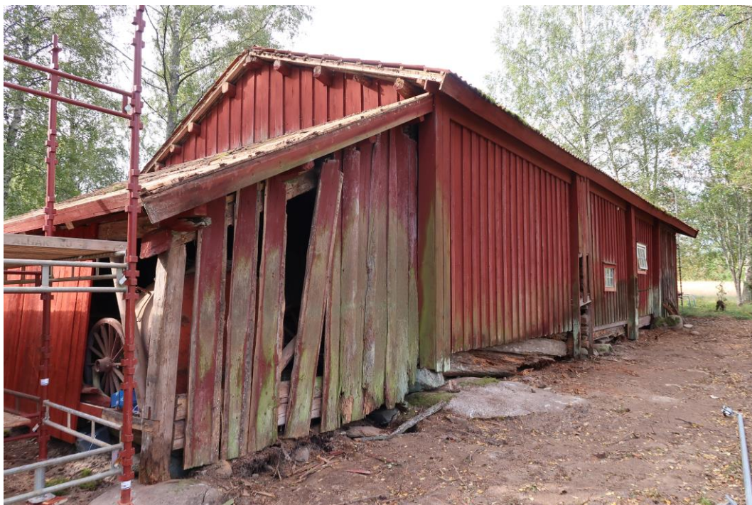
Panelen på norra sidan av logen. Marken har planats ut och växtligheten tagits bort. Nedre delen av panelen har också tagits bort.
