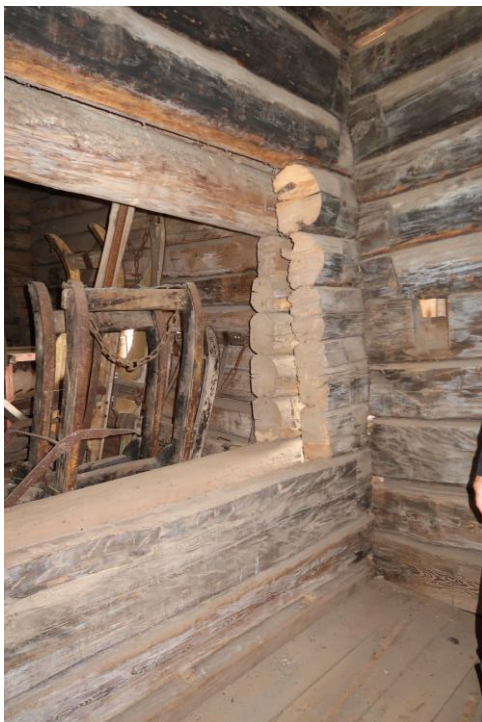
Timmerstommen inne i rian, mot logen. De har senare uppsågade öppningar mellan sig.
