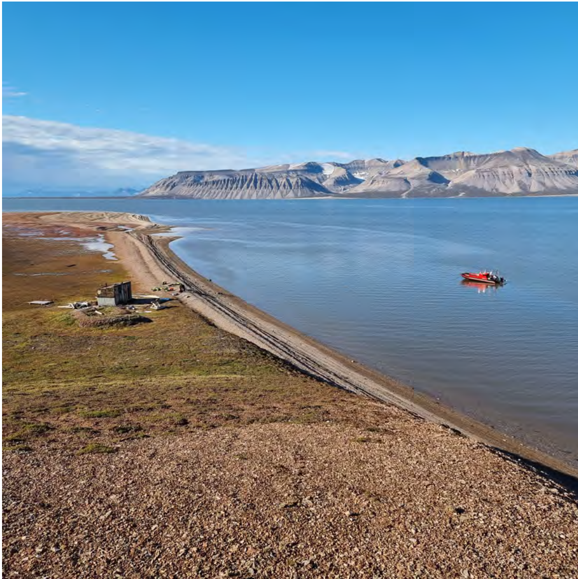
Restaureringsarbeid av Tåkefjellhytta ved Nordre Bolleneset sommeren 2023. Hytta ble bygd av Arthur Oxaas og Peder Pedersen. Harald Soleim brukte den som bistasjon.. Foto: Erki Markson
