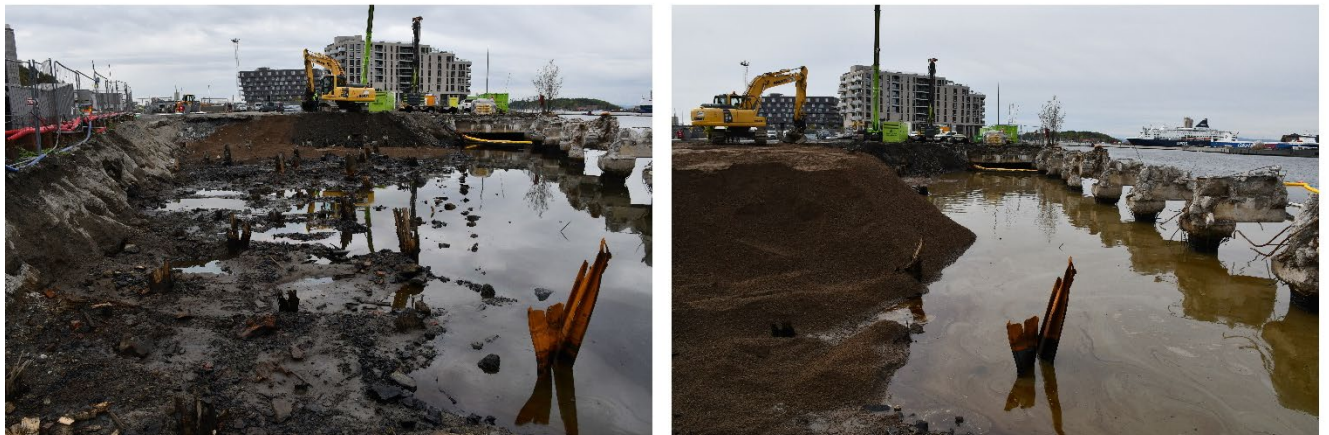
Figur 8: Til venstre: området sørøst for kaifronten etter det ble forgravd ned til kote 0 ifm. spunting. Til høyre: området sørøst for kaifronten blir gjenfylt med grus. Bilder tatt mot sørvest av Lin C. Hobberstad, NMM.
