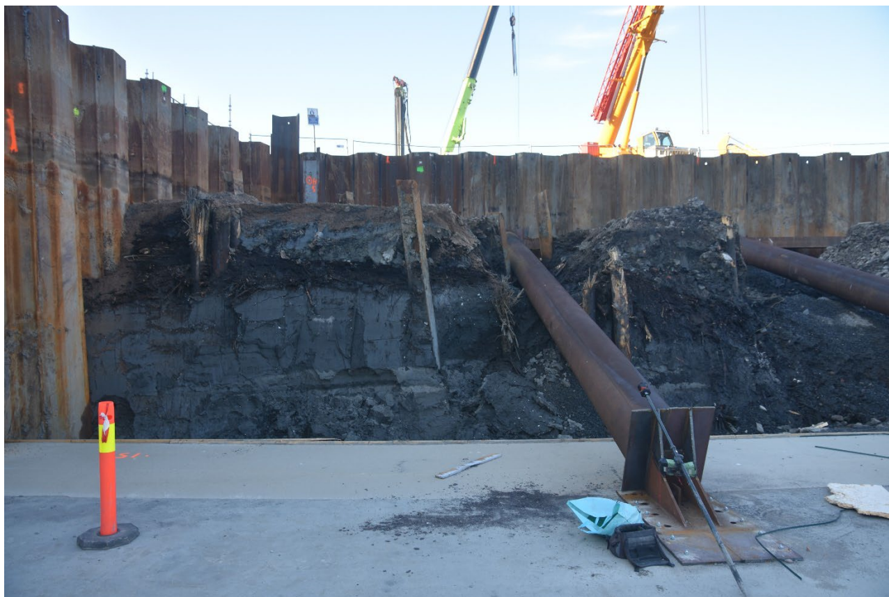
Figur 9: Støpt arbeidsdekke og avstivere mot sørsfunten. Bilde tatt mot sør av Sjoerd van Riel, NMM.
