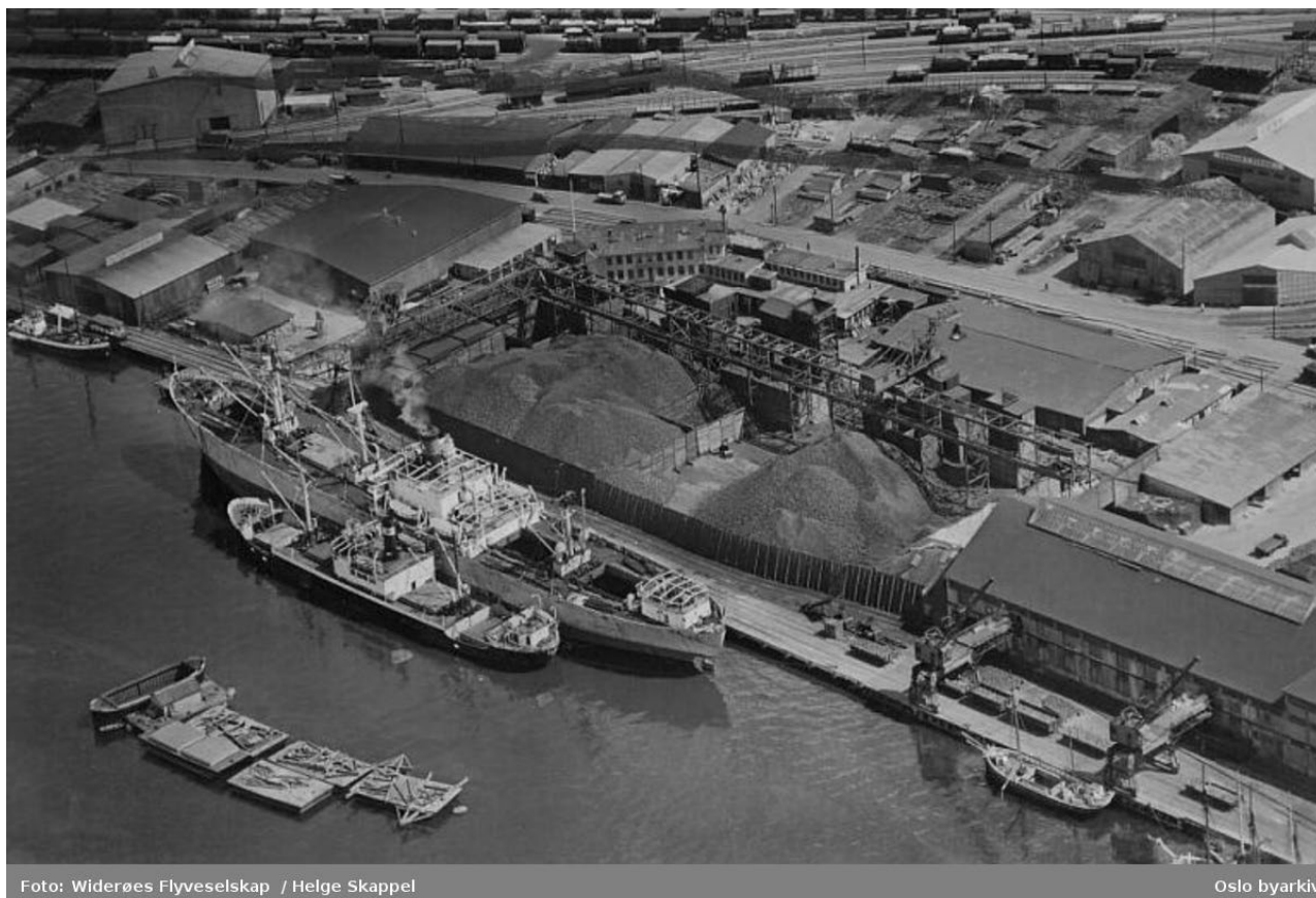
Figur 18: Flyfoto fra 1951 som viser bygningene til Forenede Kulimportører og kaianlegget. Foto: Widerøes Flyveselskap / Helge Skappel / Oslo byarkiv.
