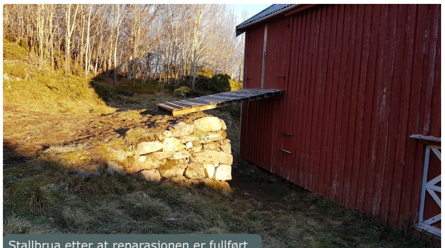
Stallbrua etter at reparasjonen er fullført
