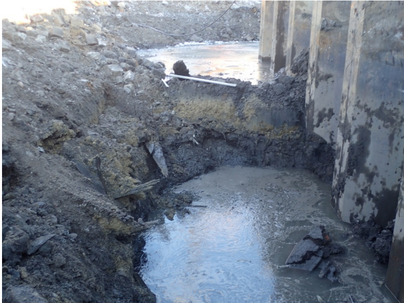
Figur 8: Spuntgrøft mot nord. Bilde viser plankedekket og sandlaget over.
