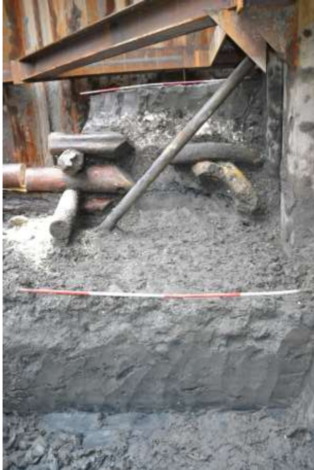
Figur 79: Prøvegrøft ned til kote ca. -5,5 moh., i vestre del av feltet. Mørk undergrunnsleire ved bunnen av grøft. Foto NMM.
