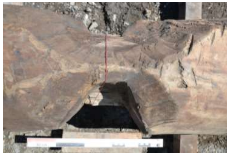
Figur 29: eksempel på Raulandslignende laftehogg fra K1005. Foto Kristina Steen, NMM
