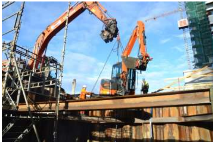
Figur 52: Løft av minigraver med stormaskin. Foto mot vest. Foto NMM.
