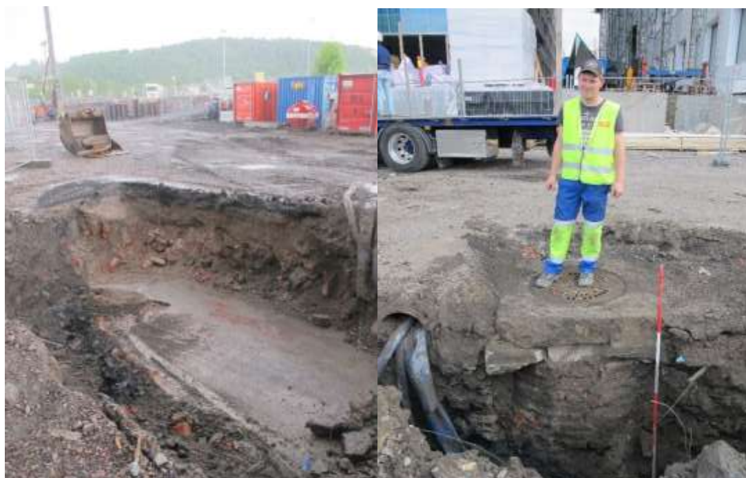
Figur 55: Til venstre et gulv/murstein fra «nyere tids bygning». Foto mot sørøst. Til høyre en kum med vegger av tegl. Gravemaskinfører Jimmy Kviltén står på kumløkket. Foto mot nord. Foto NMM.
