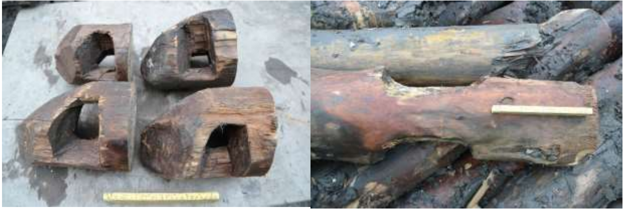
Figur 62: Til venstre er eksempler på stokkeender med slepehull fra «bunnflåten» på K2002. Slepehullene er tildannet med øks. Til høyre er en stokk fra laftekasse K2002, eksempel på uthogg for kryssende stokker. Foto NMM.
