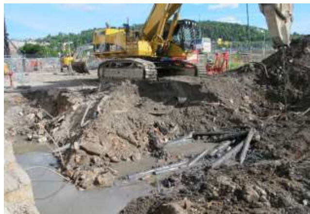
Figur 51: Opptrekk av løsmassestag. Tømmerfundament og tegl i grunnen fra "nyere" bygning. Foto mot øst. Foto NMM.
