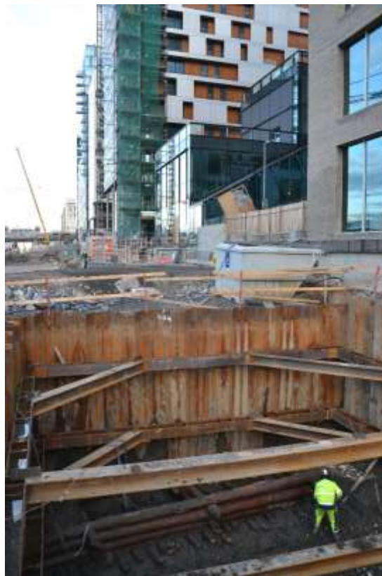
Figur 60: Bolverk K2002. Bunn på kote ca -4,5 moh. Foto mot vest. Foto NMM.
