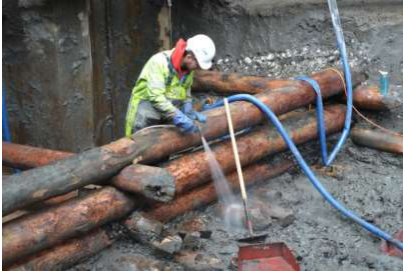
Figur 53: Spyling av laftekasse K2002. Foto mot nord. Foto NMM.
