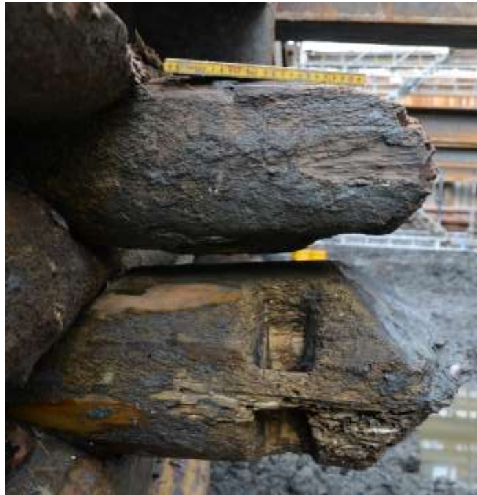
Figur 65: Spor etter pelekrepsangrep, laftekasse K2000. Foto NMM.
