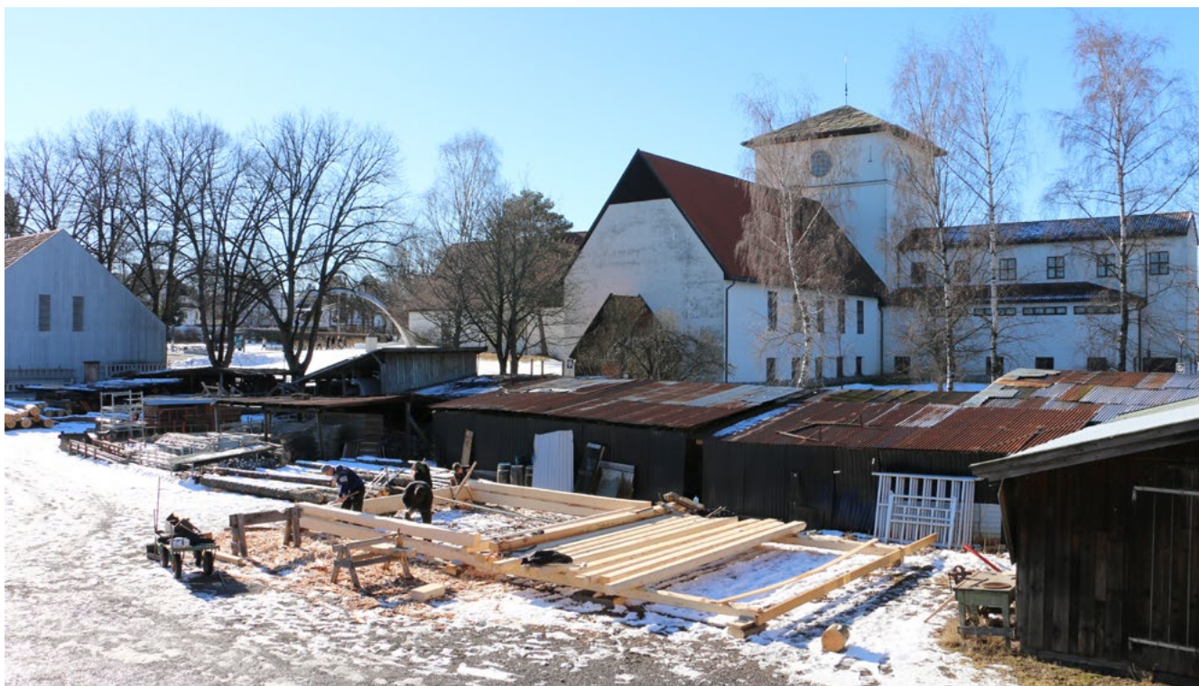
Museumshåndverkere ved Norsk Folkemuseum bygger verksted. Prosjektet inngår i håndverkernes bachelorutdanning i bygningsvern. Gjennom oppføringen av nybygget videreføres håndverkstradisjon og -kunnskap. Bygget skal huse snekkerverksted og ei smie, og den immaterielle kulturarven vil stå i sentrum også etter at bygningen er ferdig. Foto: Henning Jensen, Bygningsantikvarisk seksjon, Norsk Folkemuseum, 2017.
