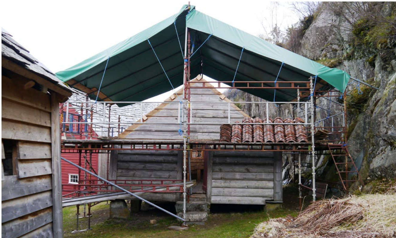
Istandsetningsarbeid på Vigatunet, Hjelmeland i regi av Ryfylkemuseet. Foto: Siv Leden.
