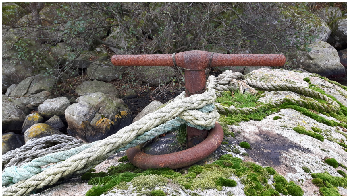
Figur 10 Eksempel på fortøyningsbolt av eldre type i planområdet (Bolt 1). Foto: Elling Utvik Wammer, NMM.
