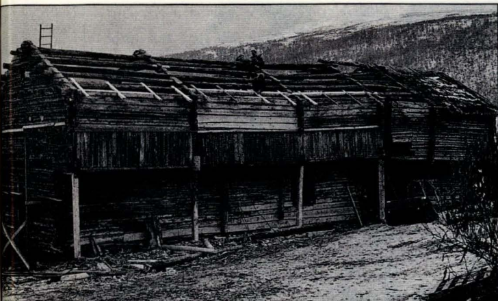
Vern av bygninger. Restaurering av låven i Nyhusa, 1991. (66406).
