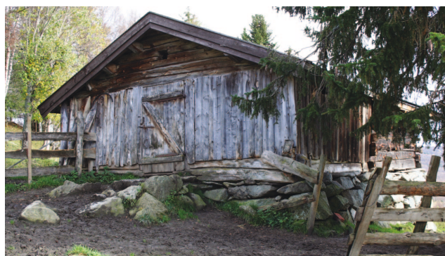
Fjøs i skjelter, eller grovt bindingsverk, Åslia, Dalsbygda.
