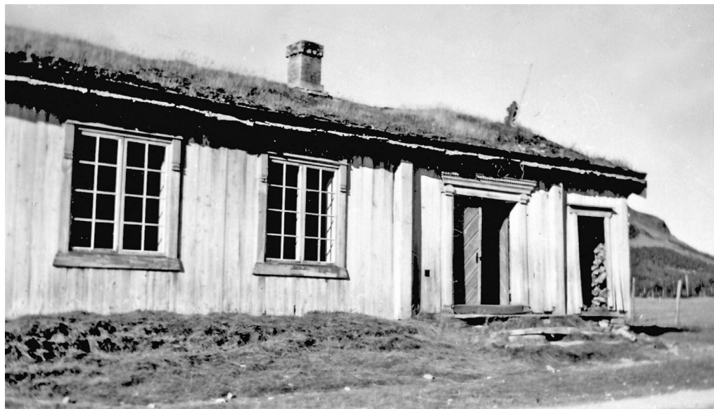
Holøyen skole. Skulehus som dette var i bruk i mange bygder i meir enn 100 år. Nå er noen av dei museum, andre har fått ny funksjon i lokalsamfunnet.
