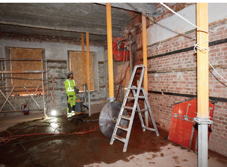
Rivearbeideren står der den nye broen i vestibylen kommer. Kraftige maskiner er i sving, mars 2016.
