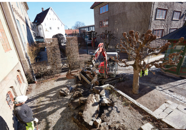
Terrenget utenfor den nye inngangen må senkes med 1 meter.
