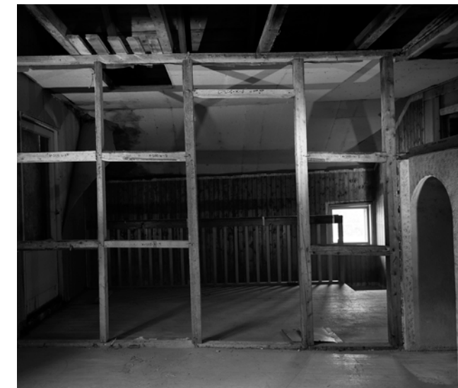
Kledningen er fjernet i et av soverommene i Olderfjord og alle delene i bindingsverket er nummerert. Huset var bygd særdeles samvittighetsfullt og presist, noe som også kan ses i den flott utførte ovnsnisjen. Bildet er utstilt i Porsanger rådhus. Foto: Haakon Harriss/Norsk Folkemuseum.
