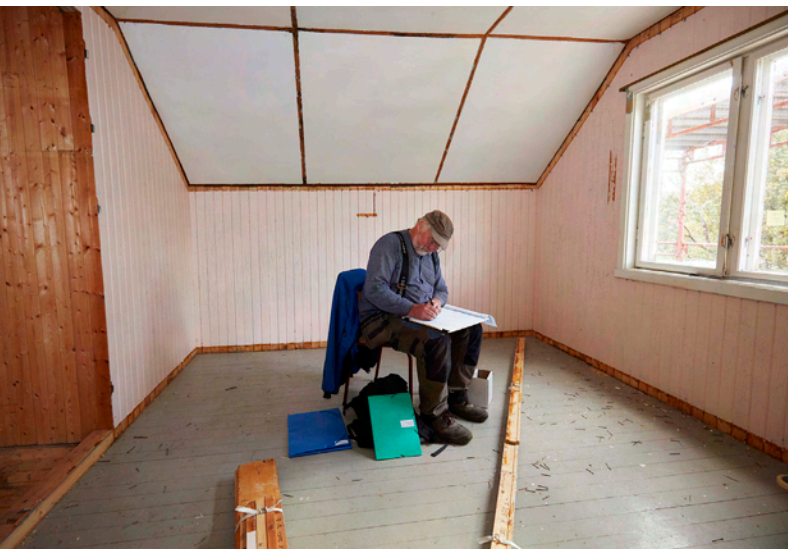
Alle rommene ble nummerert og veggene fikk en bokstav. Videre fikk alle bygningsdelene sin merking og plassering i dette systemet. Her sitter Ole Jørgen Schreiner fra Norsk Folkemuseum i et av soverommene i Olderfjord og registrerer listverk. Bildet er utstilt i Porsanger rådhus. Foto: Haakon Harriss/Norsk Folkemuseum.
