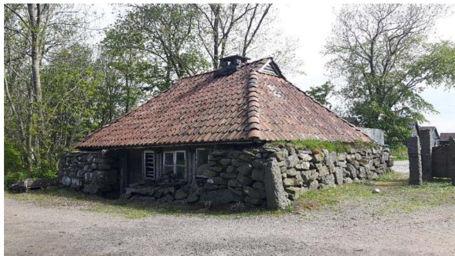
Figur 110 – Motlandsmia er ein av bygningane som står høgt på prioriteringslista for istandsetjing.
