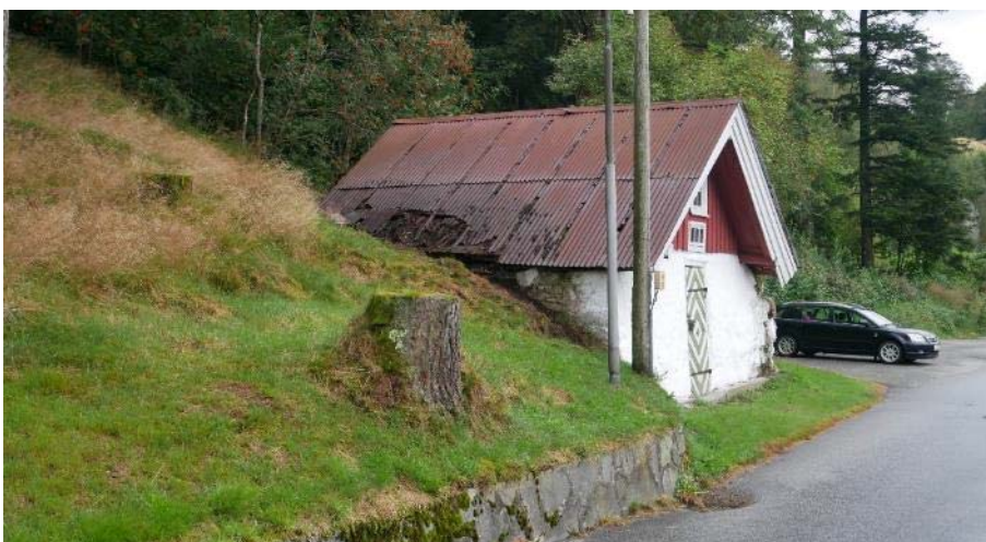
Figur 99 – Potetkjellaren på Slettebø er vurdert til tilstandsgrad 3. Museet planlegg restaurering av bygget i 2020. I prosjektet vil det særskilt bli jobba med kompetanseheving og dokumentasjon..
