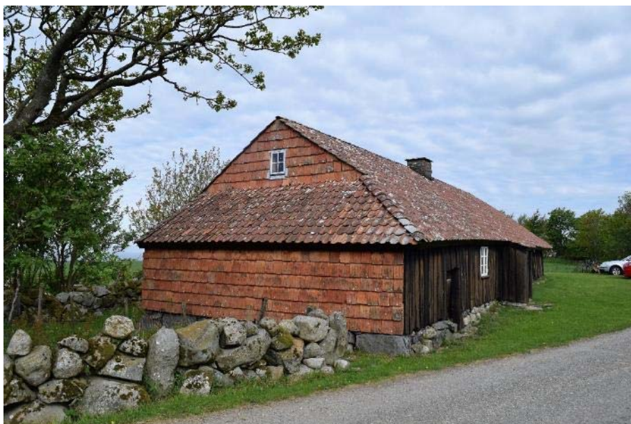
Figur 49 – Gamla huset, eit av stovehusa på Grørdaland.
