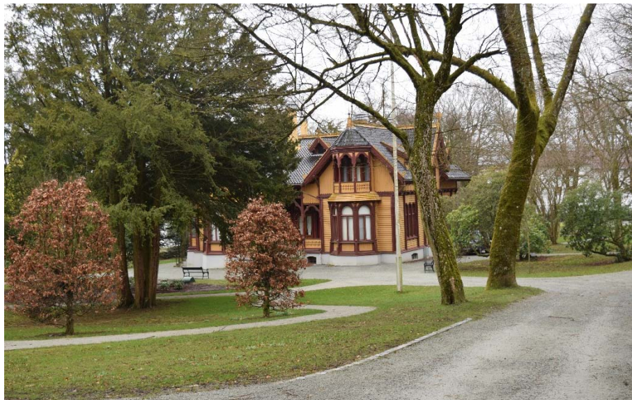
Figur 91 – Breidablikk er vurdert til tilstandsgrad 3.
