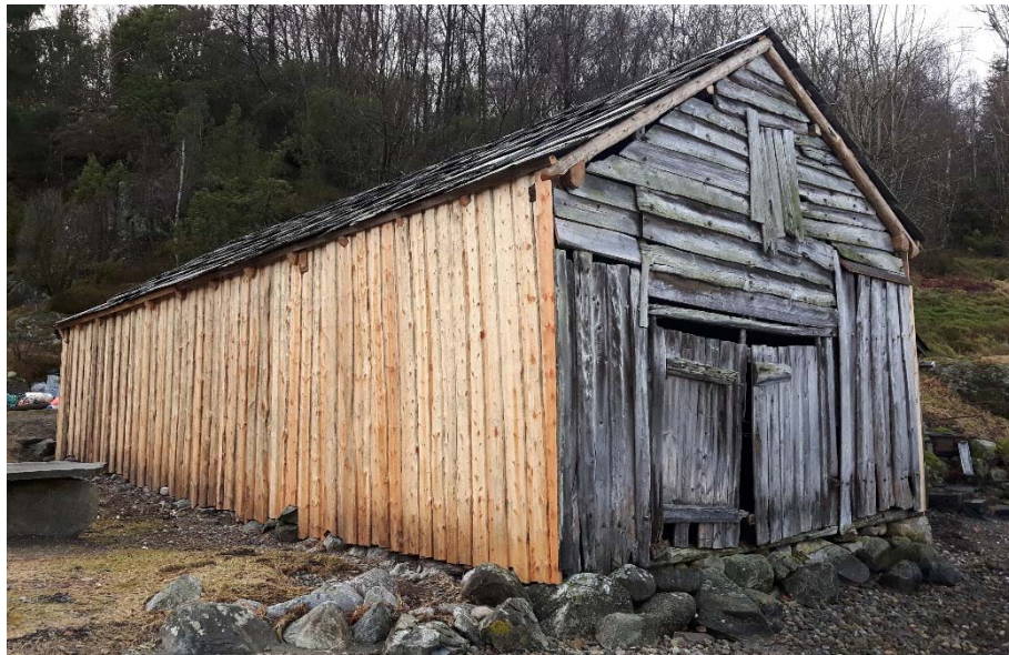
Figur 102 – Naustet i Vigavågen (Hjelmeland kommune) høyrer til Ryfylkemuseet og er eit av bygga som blei sett i stand med sysselsetjingsmidlar i 2016. Delar av stavkonstruksjonen måtte bytast. Det same gjaldt sperretaket. I tillegg blei det lagt ny kledning, og taket blei tekt med dei same villhellene som tidlegare. Bygningen blei slik løfta frå TG3 til TG1.
