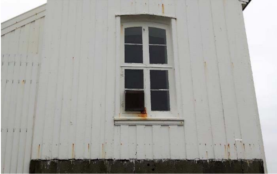
Figur 138 – Fyrbygningar er truleg dei bygningane som blir utsette for størst påkjenningar av vêr og vind. Her er fyrbygningen på Tonjer. Sjølv kort tid etter at bygningen er måla, kjem rustflekkene fram. Den salte og fuktige lufta gjer vedlikehaldet til ei stor utfordring.
