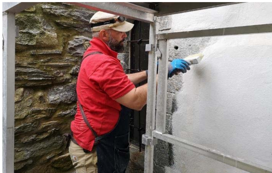
Figur 132 – Mathies Ekelund Erlandsen kalkar veggene på Utstein kloster. Foto: MUST.
