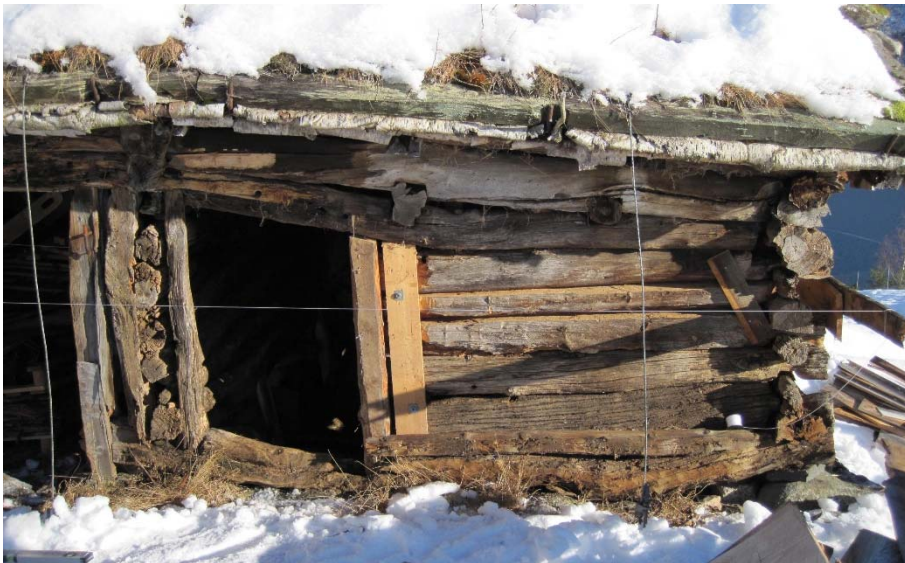
Figur 17 – Løa var flikka på og vølt etter beste evne så lenge at det var vanskeleg å finne hald for nye reparasjonar. Her er bilete frå dokumentasjonen og oppmålinga av løa i februar 2013. Kledningen er demontert i samband med dokumentasjonsarbeidet.
