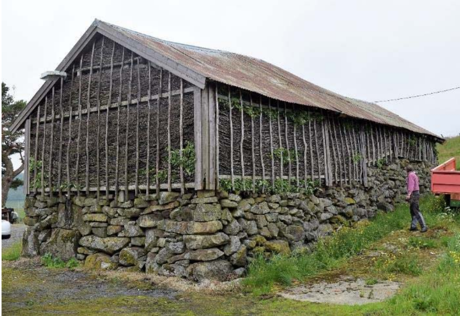
Figur 61 – Fagardløa på Barstad. Dette er ein viktig del av byggjeskikken i Dalane. Det er svært få slike løer att.
