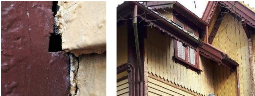
Figur 134 og figur 135 – Målinga var tidlegare påført i tjukke lag (jf. dropane på kledningsborda). Det viste seg naudsynt å skrapa ned til dei inste laga før dei målar opp igjen veggen med linoljemåling. På biletet til høgre er den ståande kledningen skrapa ned. Her blei det i 2019 måla prøvefelt.
