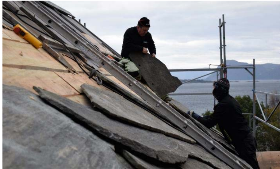
Figur 72 – Handverkarar ved Haugalandmuseet tekte om den vølte løa på Veien med villheller i 2017.
