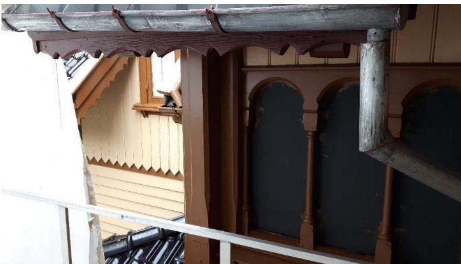
Figur 136 – Prøvefelt på fasaden på Breidablikk. Til venstre ser me den nye fargen (sandfarge) med brunmåla detaljar.
