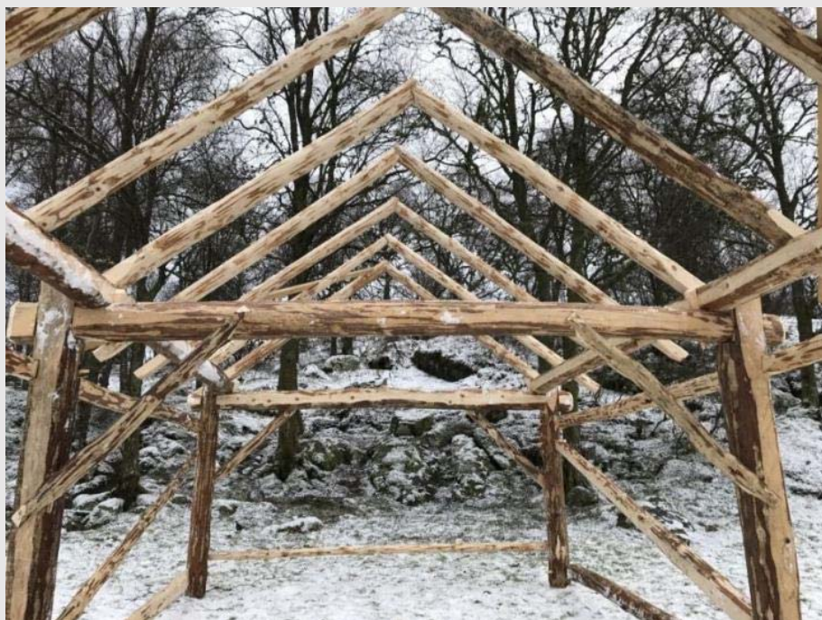
Figur 118 – Eit nytt bygg i stavkonstruksjon (grindbygg) på Rossøy. Dette blei bygd av handverkarane på Ryfylkemuseet som ein del av bachelorutdanninga i tradisjonelt bygghandverk (NTNU). I forarbeidet brukte dei tid på å studera lokale bygg for å finna eit som kunne brukast som førebilete/mal for ein rekonstruksjon. Oppgåva gav handverkarane ny kunnskap om denne konstruksjonstypen.
