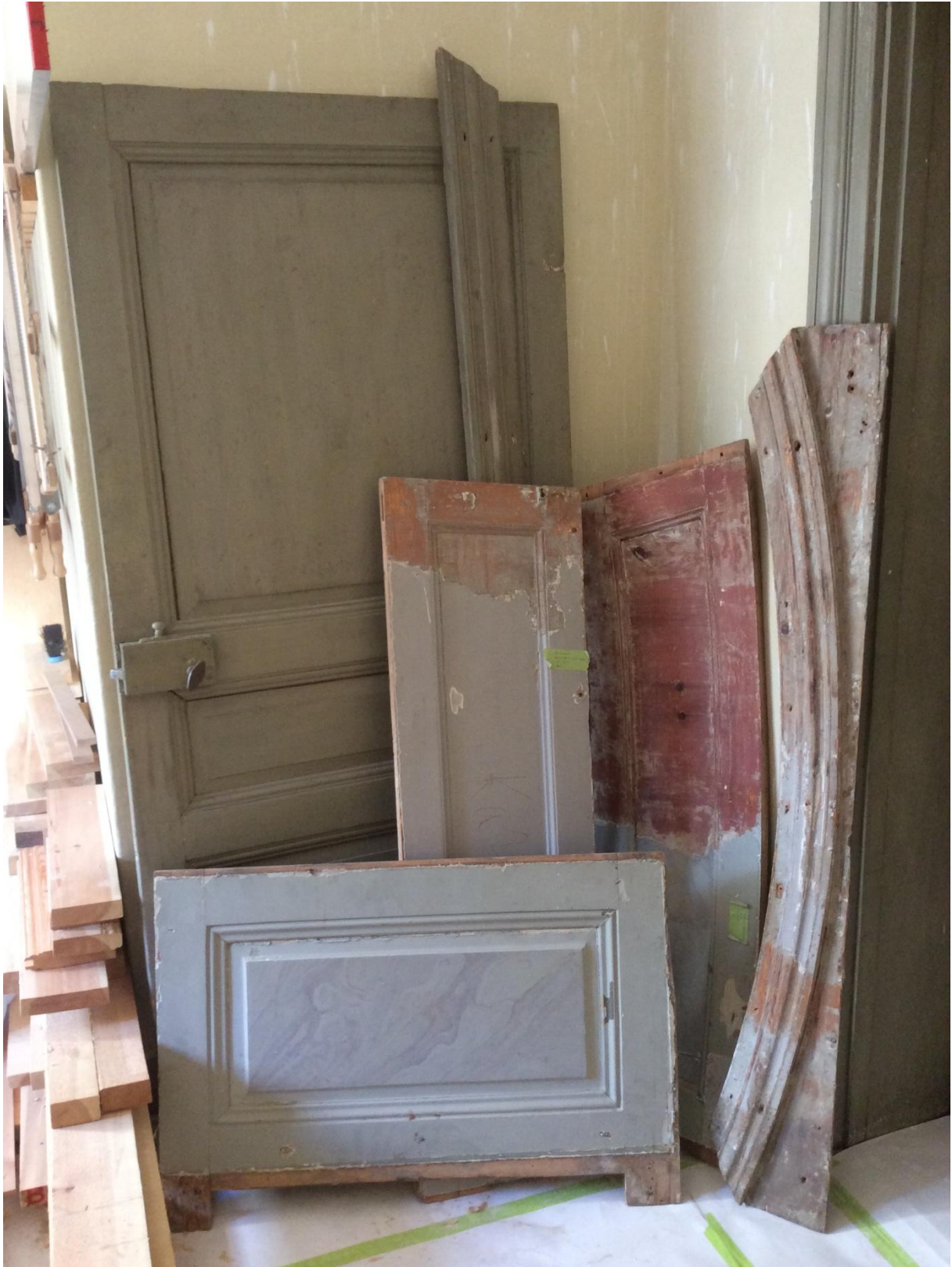
Några av våra förlagor. Halvfransk dörr, ett rakt- och ett svängt foder, en bröstpanel, en rak och en svängd fönsternischpanel.
