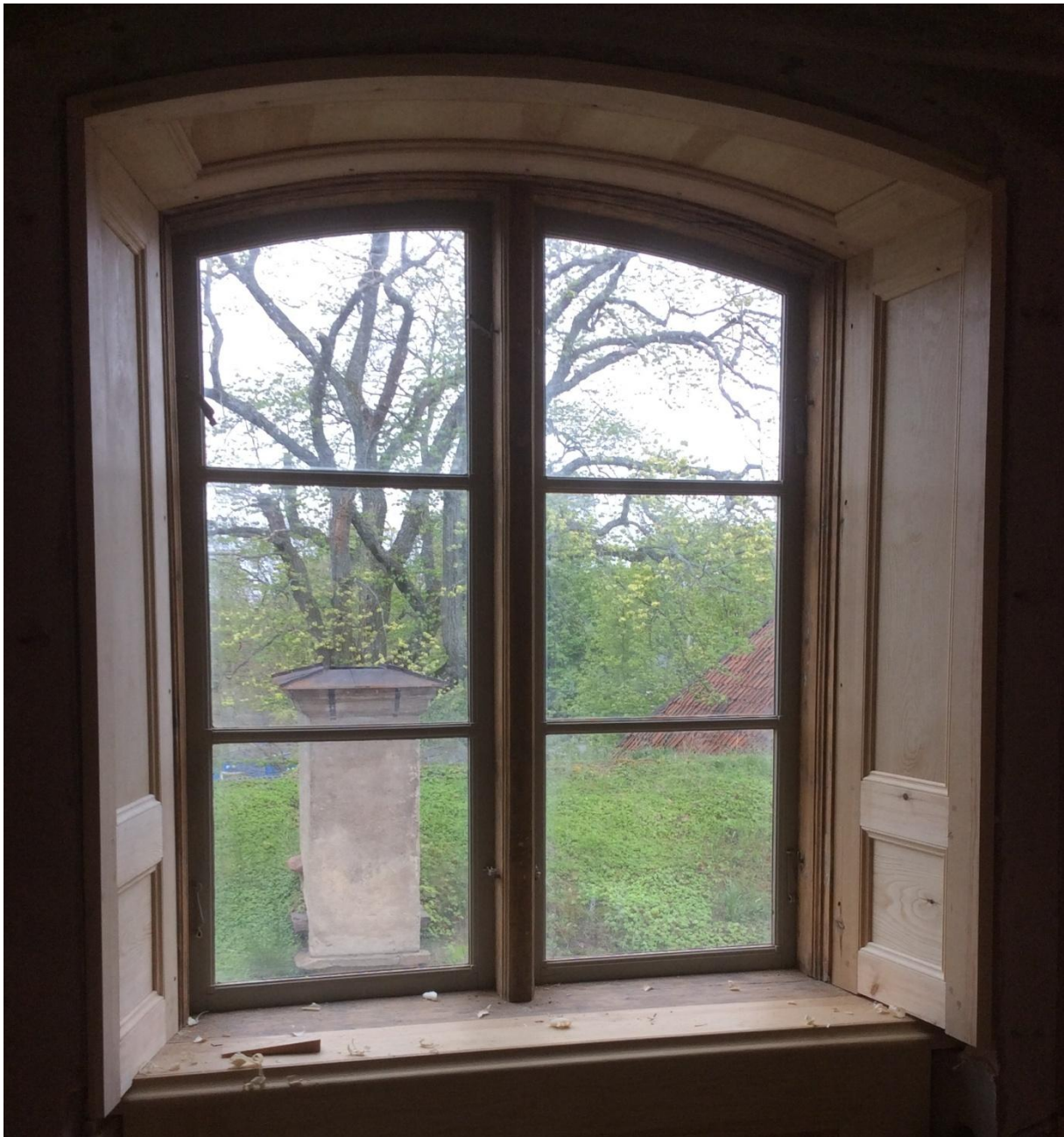
Fönsternischer på plats och fastspikade
