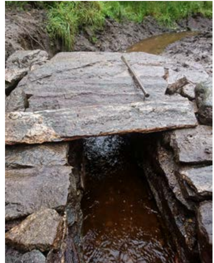
Etter konferanse med vegvesenet landa vi på at veita skulle utførast slik ho var laga i si tid, det vil seia utan heller i botnen. (Foto: Berit Bruvik)
