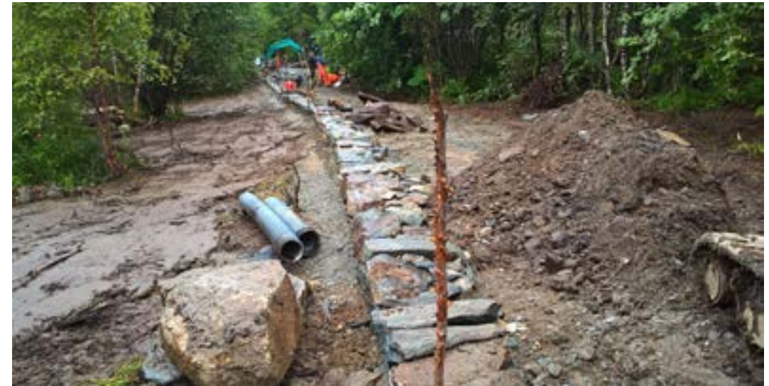
Etter kvart som arbeidet med å leggja kantmuren skreid fram, vart det også lagt fyll, fyllstein eller meir samfengde massar inn i vegkroppen. (Foto: Hakon Aase)
