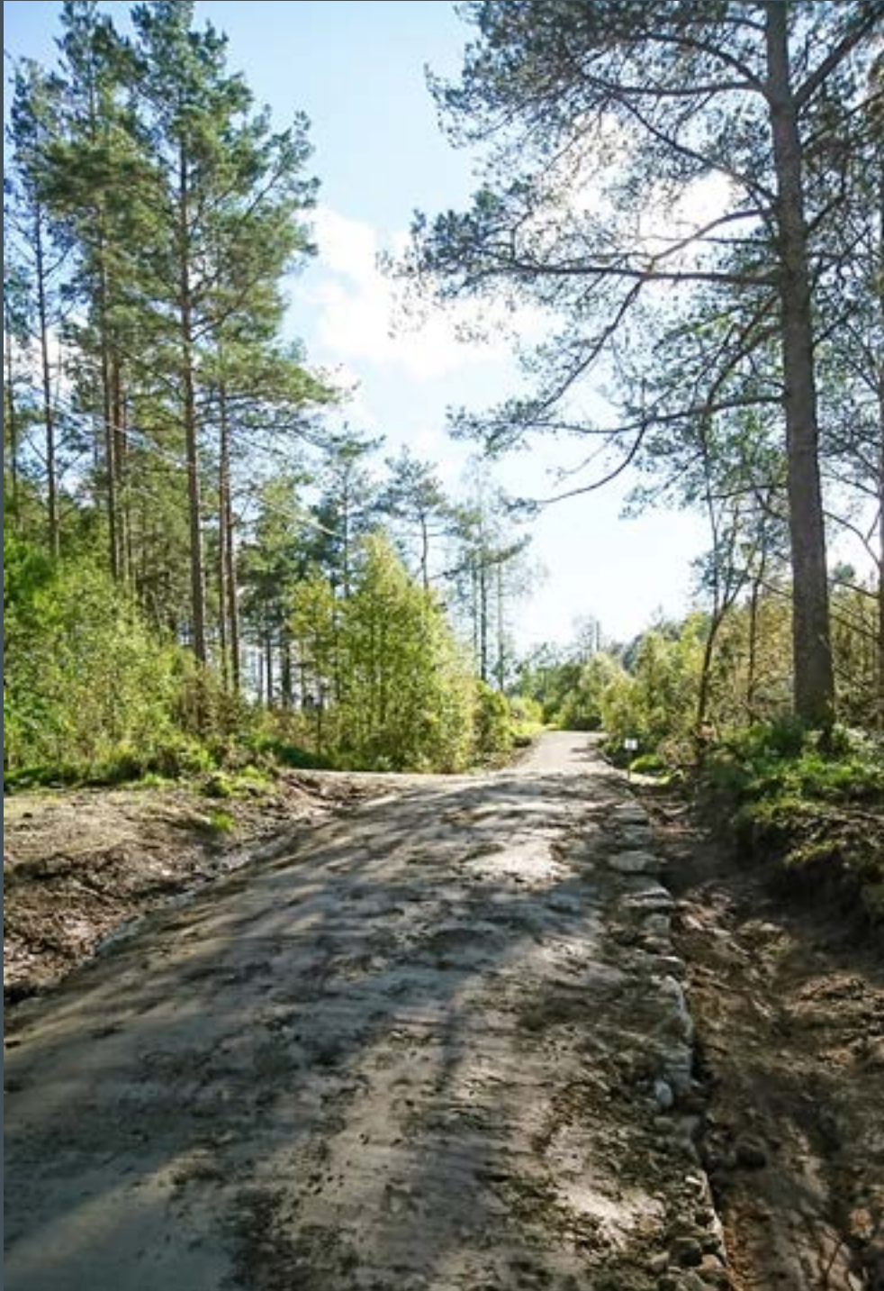
Arbeidet med tilbakeføring/istandsetjing av den Trondhjemske Postvej over Våge i Lindås kommune vart utført sommaren 2017. (Foto: Haakon Aase)
