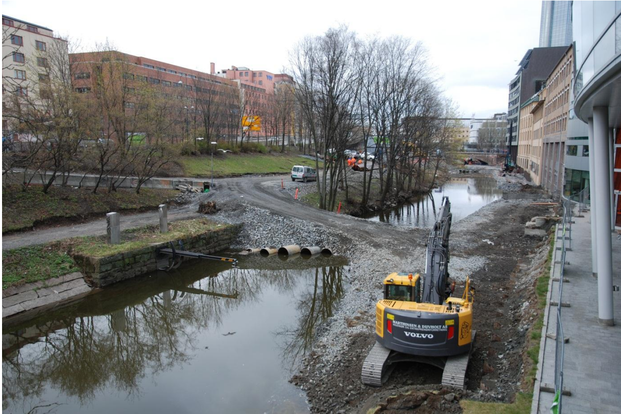
Figur 7: Området sør for Hausmanns bro, mot Vaterland, i anleggsperioden.
