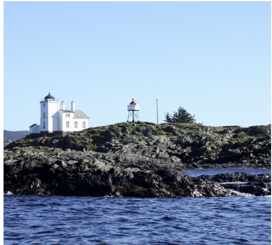
Fyret på Sørhaugøy, populært kalt Tonjer fyr, forteller fyrhistorien fra 1846 og fram til det ble automatisert i 1952. Fyret ble bygget som ledfy, for å vise vei for sildefiskerne. Fyrboligen med tilhørende sjøhus, eies av Karmsund folkemuseum og har vært under restaurering 2011 – 2017. Foto: Grethe Paulsen Vie, Haugalandmuseene
