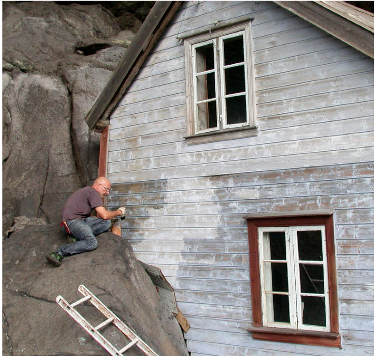
Dalane Folkemuseum overtok eierskapet til de to små, godt besøkte husene i Hellenen, Jøssingfjord, tidlig på 2000-tallet. Olav W. Thomassen påfører det ene linolje. Foto: Dalane Folkemuseum
