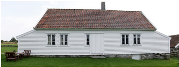
På Vistnes er det et helt tun med gårdsbygninger, noe Jærmuseet forvalter sammen med Randaberg kommune. Foto: Håvard Tørresen, Jærmuseet
