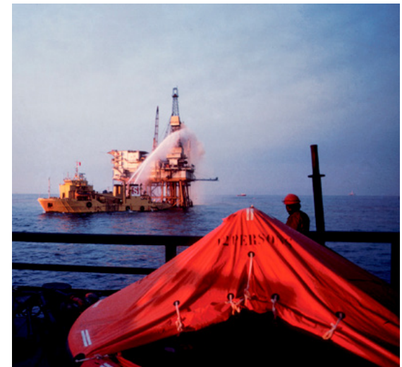
Utblåsningen på Ekofisk 2/4 B. Supply-, redningsbåten "Seaway Falcon" spylar vann opp i gasstrømmen. Foto: fotograf ukjent, Norsk oljemuseum
