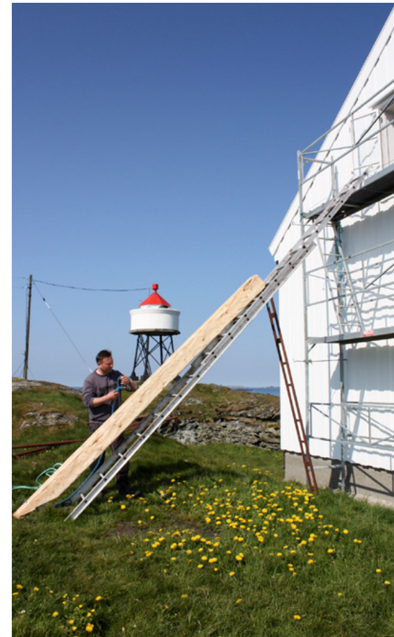
Håndverker Mariusz Buryj gjør klar en golvbjelke før løfting inn vindu i 2. etasje. Bildet er tatt i 2012 under restaureringsarbeider på Sørhaugøy fyrstasjon i Haugesund. Foto: Grethe Paulsen Vie, Haugalandmuseene
