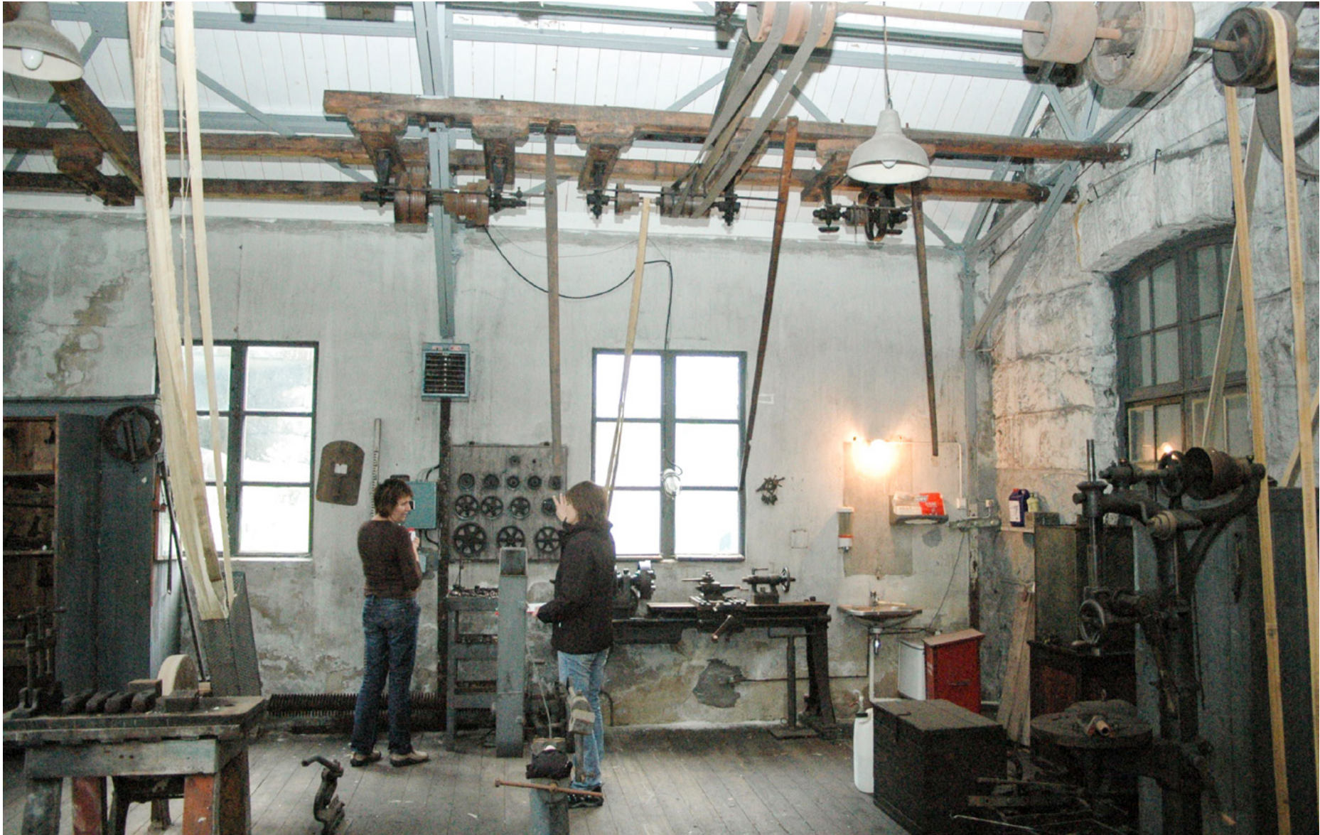
Mekanisk verksted i Jøssingfjord før restaurering. Verkstedet ble bygget ca. 1920 i tilknytning til kraftstasjonen. Prosjektleder Bess Grastveit og konservator Olaug Økland i bildet. Foto: Dalane Folkemuseum
