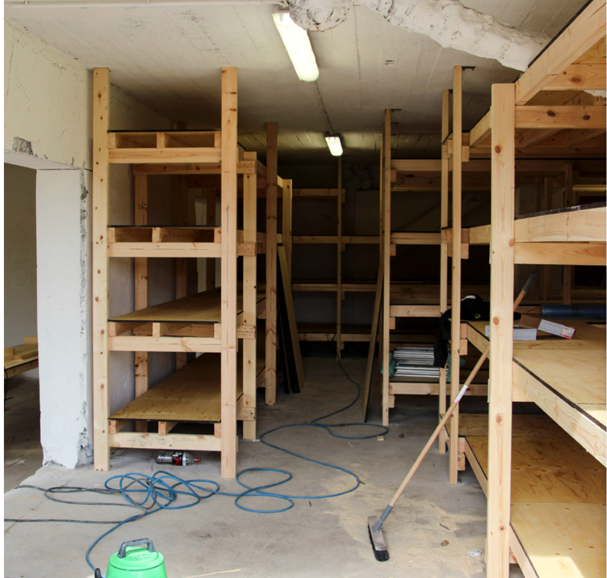
Nytt magasin for gipsformer under bygging. Foto: Dalane Folkemuseum
