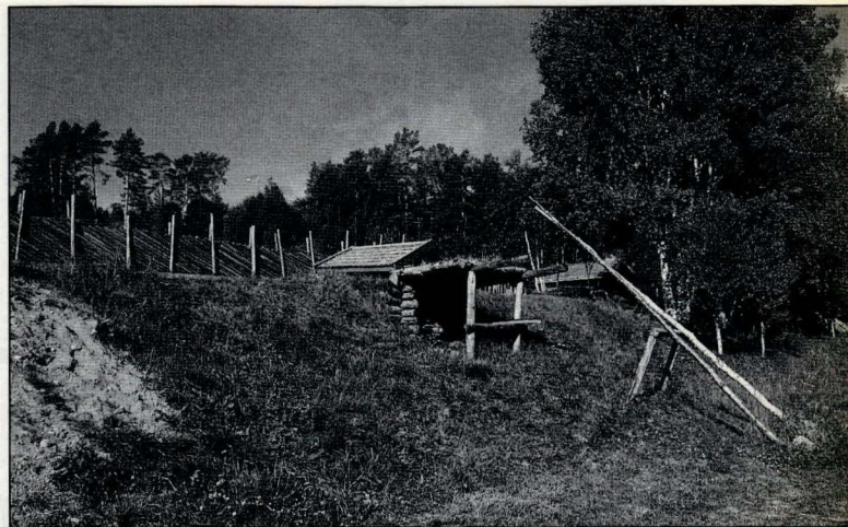
Jarnblestringsanlegget på Dølmotunet.
