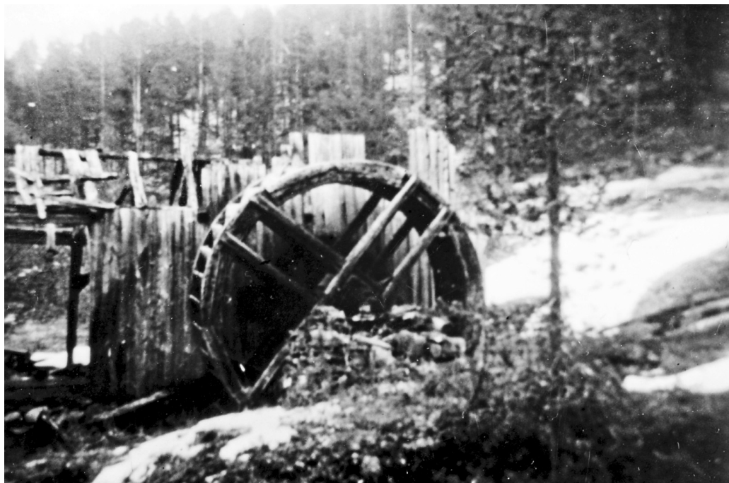
Rester av oppgangssag med overfallshjul i Sagbakken. Nordøsterdalsmuseet nr. 46220.
