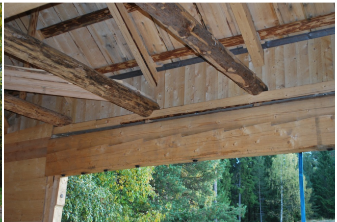
Konstruksjonen av en kammet drager
