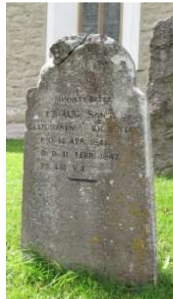
Bilderna ovan visar på olika skador som flera av gravvårdar av kalksten kan ha. Vittring, skador efter frostsprängning, sprickor m.m.
