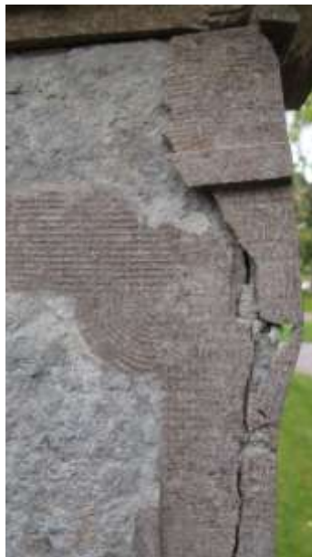
Bilderna ovan visar på olika skador som flera av gravvårdar av kalksten kan ha. Vittring, skador efter frostsprängning, sprickor m.m.
