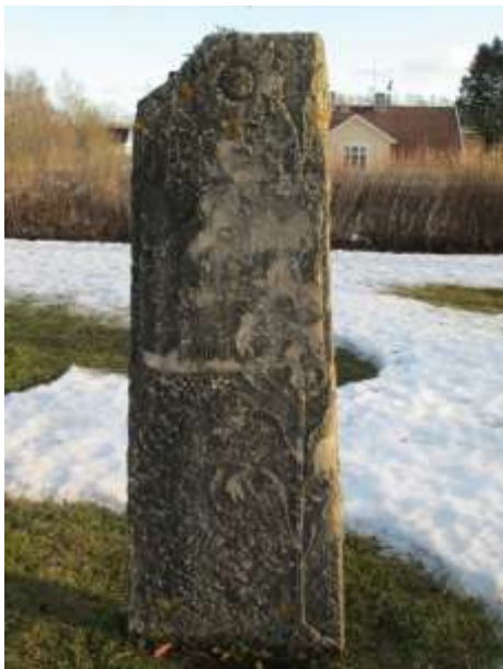
Bilderna ovan visar på olika skador som flera av gravvårdar av kalksten kan ha. Vittring, skador efter frostsprängning, sprickor m.m.
