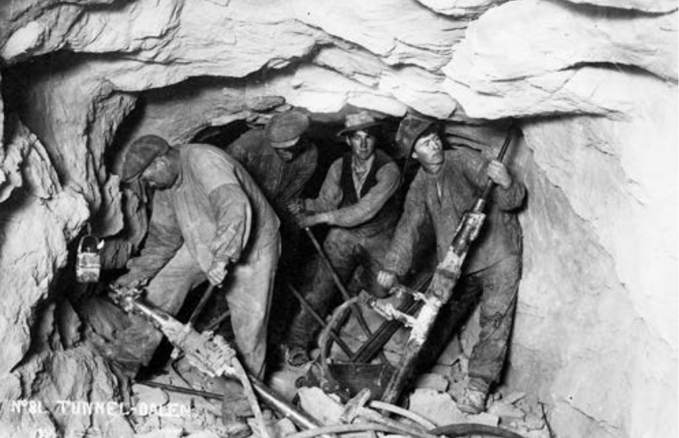
Et av bildene i utstillinger merket "Tunnel-dalen" viser litt moderniserte rallare med tidlig maskinboring ved Aura-utbyggingen i 1914. Arbeidet var hardt. (Foto: Hans Johnsrud)
