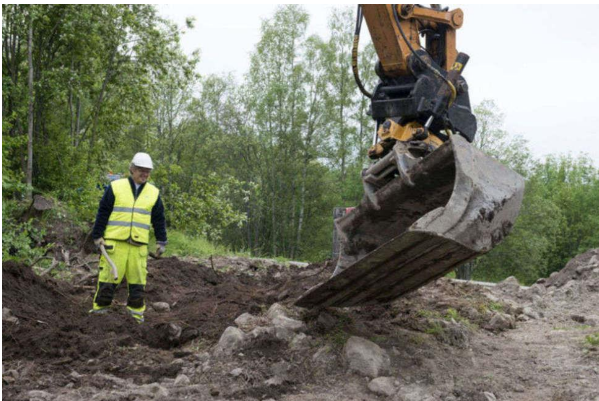
Ulf Fransson övervakar grävarens arbete, den har behövts för att få fram konturerna av själva graven.
