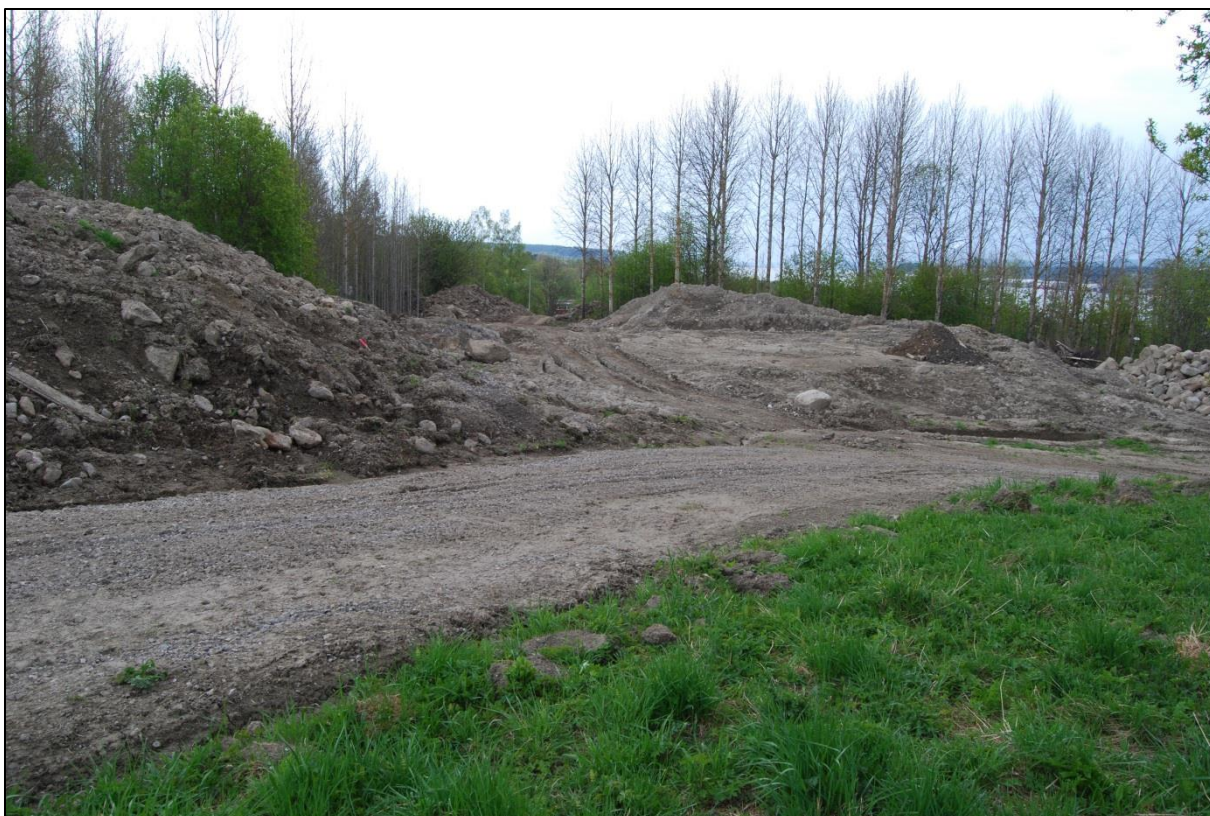
Fig. 9. I förgrunden tillfällig väg och schaktmassor på ytan mellan Raä 58 och Raä 59. I öppningen mellan träden, mellan de bortersta jordhögarna, är platsen för graven Raä 59. Foto mot S-SÖ.
