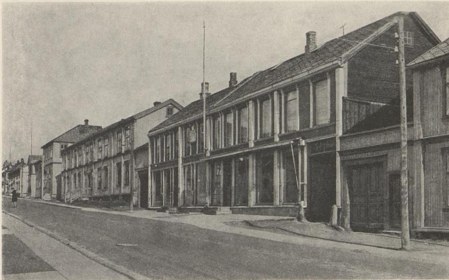
Fra Bergmannsgata. Nederst hjørnet av Bergskrivergården. Det mishandlede hus ovenfor er Leighgården, det kan rettes på. Så kommer direktørboligen som skal restaureres. Det nyere sangerhuset ovenfor må ubetinget i støpeskjeen.
