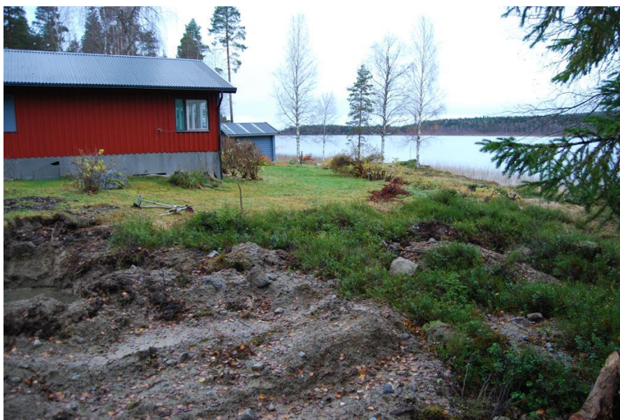
Fig. 2. Provgropen för det blivande avloppet och platsen för schaktet i förgrunden.
